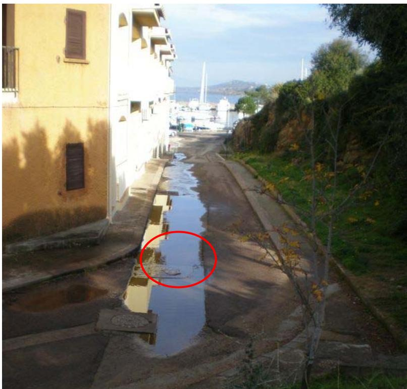
Par ailleurs, à ce niveau, un Té permet d'accéder à l'émissaire et la commune suspecte une casse du réseau. L'inspection vidéo permettrait de mettre en évidence les éventuelles anomalies.
